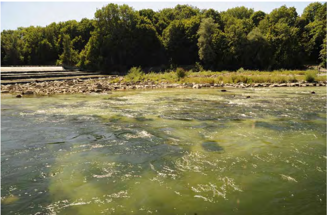
Abb. 1: Unterwasser des Eisenbahnerwehrs am Lech in Augsburg 2012
