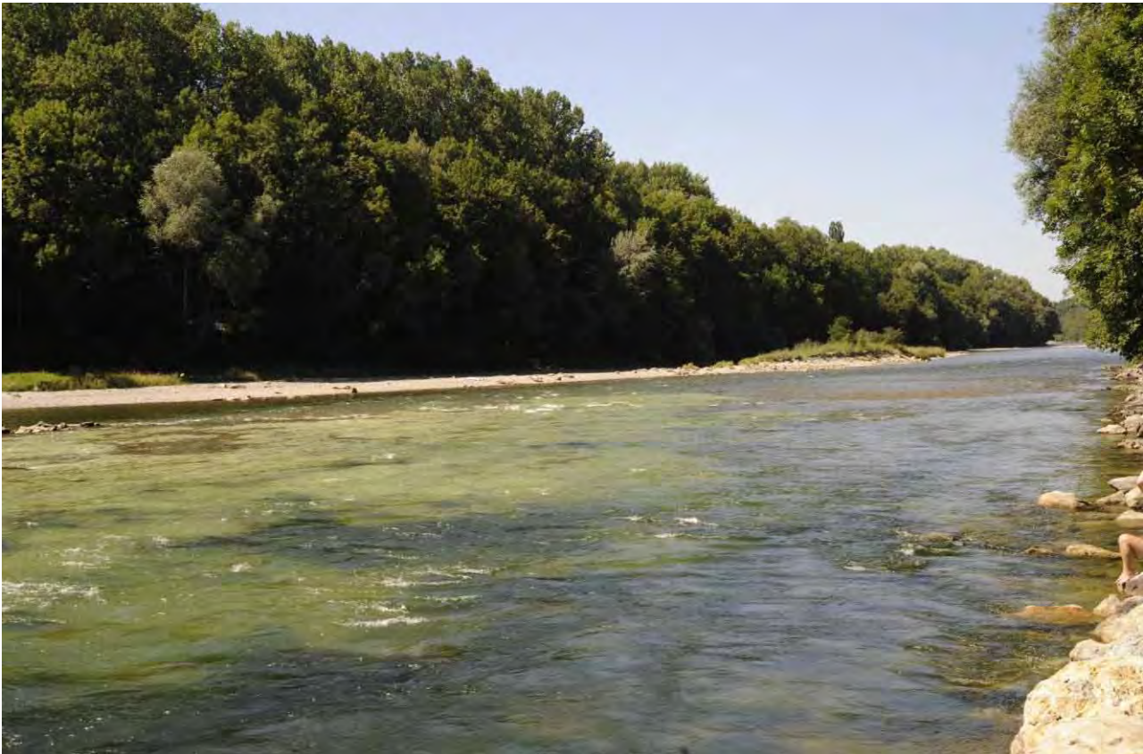
Abb. 4: Unterwasser des Eisenbahnerwehrs am Lech in Augsburg 2012
