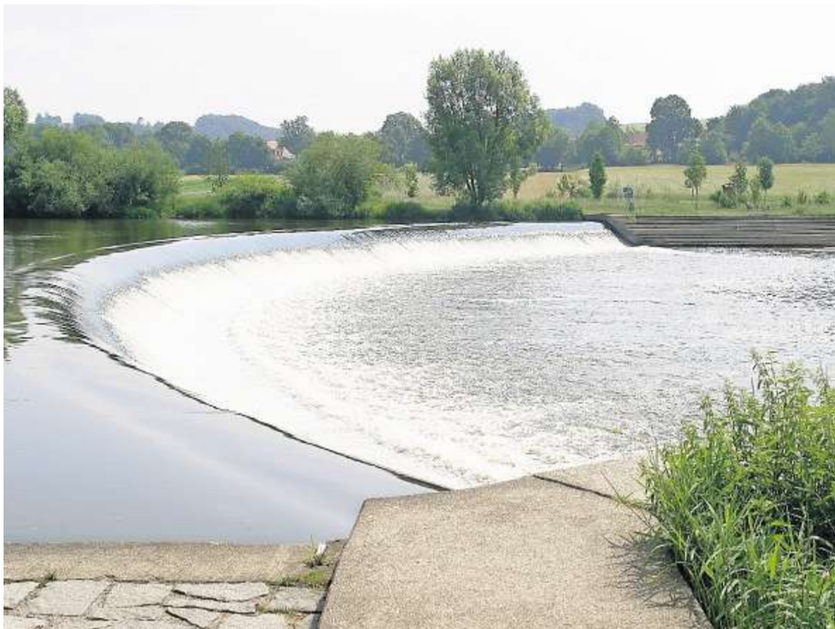
Auf der Zeitlarner Seite des Pielmühler Wehrs (im Hintergrund) will die Bayerische Landeskraftwerke GmbH ein Wasserkraftwerk mit zwei Turbinen errichten. Die Donau-Naab-Regen-Allianz lehnt das Projekt ab. Sie sieht vor allem den Naturschutz im ökologisch wertvollen Unterlauf des Regens gefährdet. Foto: MZ-Archiv
