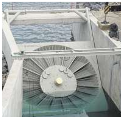
VLH-Turbinen sind sehr flach und eignen sich gut für Wasserkraftwerke mit geringerer Fallhöhe. Foto: privat
