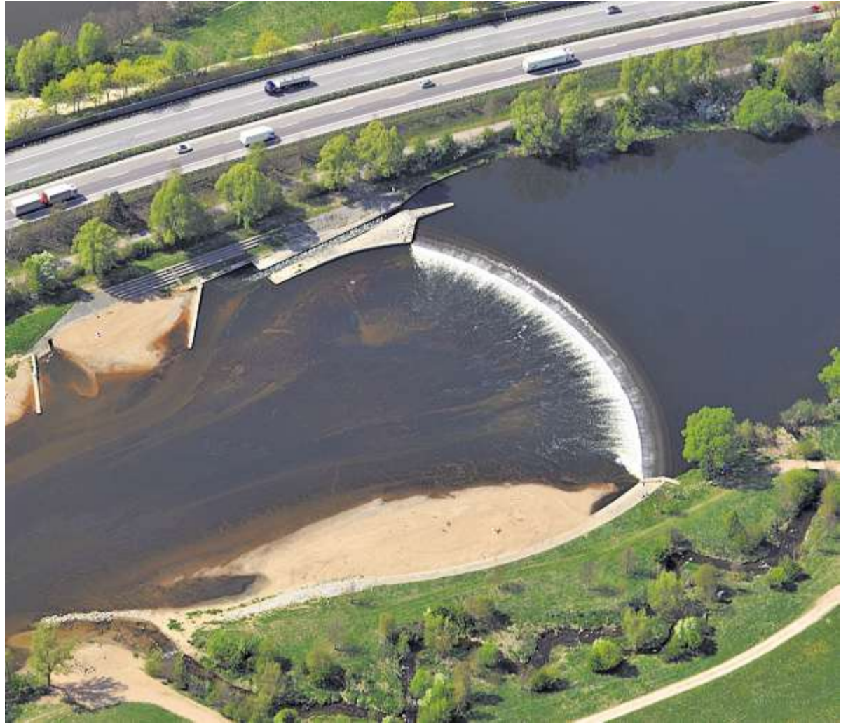
Die Bayerische Landeskraftwerke GmbH, ein Unternehmen des Freistaats, will am Pielmühler Wehr ein Flusskraftwerk errichten. Es soll auf der Zeitlarn Seite (im Bild unten) liegen. Foto: Nürnberg Luftbild, Hajo Dietz
